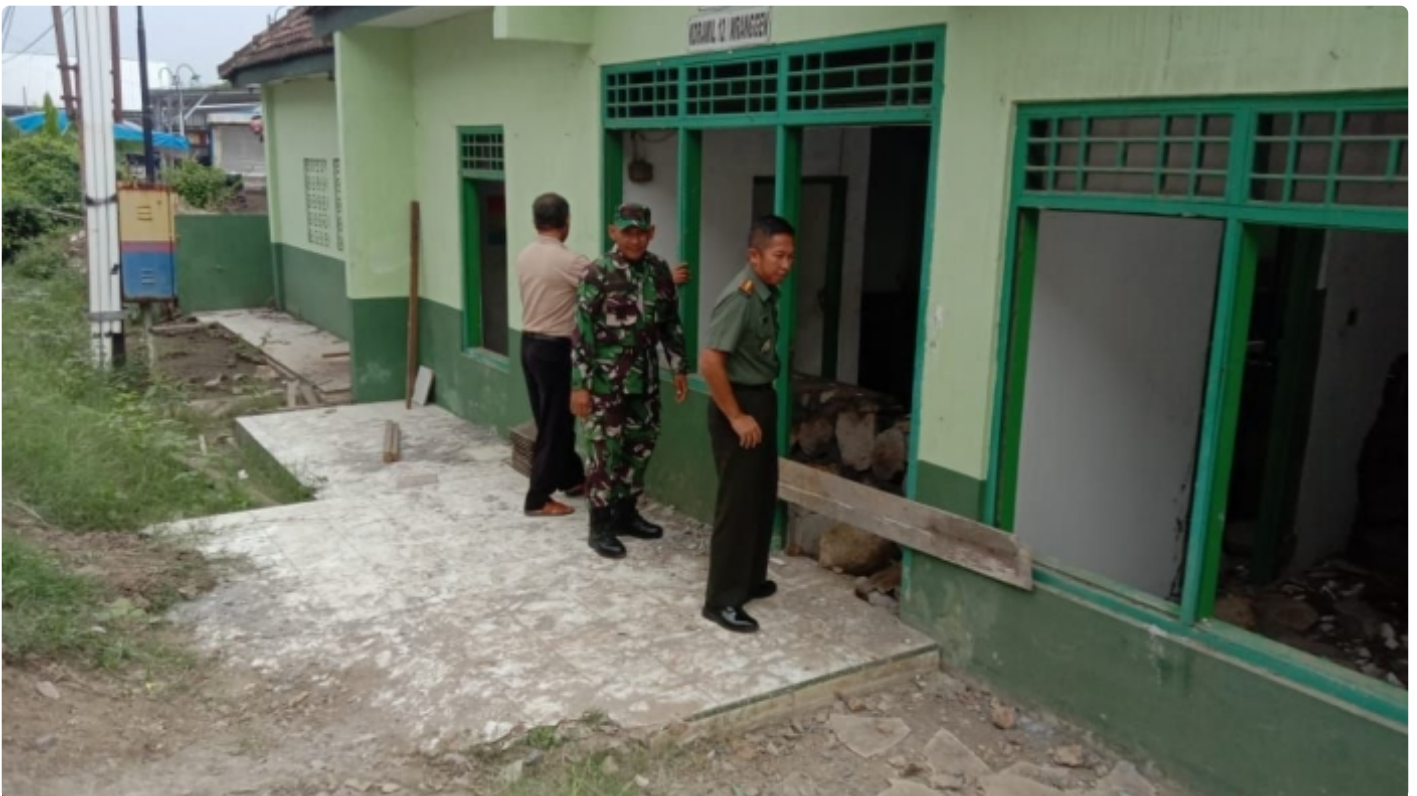
Kegiatan Dandim Demak Tinjau Pelaksanaan Renovasi Koramil 12/Mranggen
